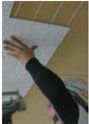
天井仕上げ工事施工
