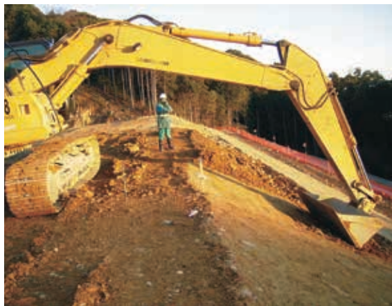
法面整形作業
