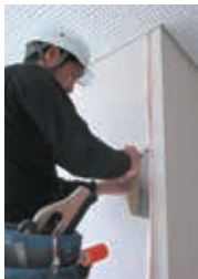
クロス仕上げ工事施工
