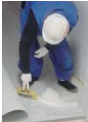
プラスチック床材施工
