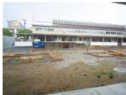
ポリテクセンター宮城 多賀城実習場
