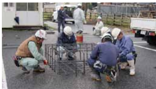
鉄筋の多能工研修
