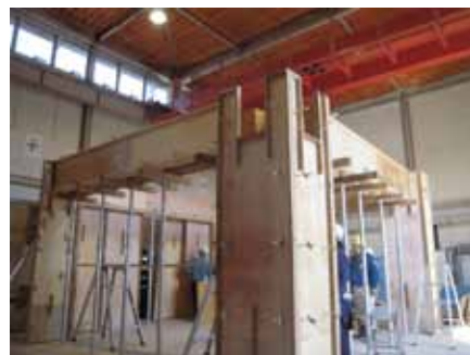
ポリテクセンター宮城 型枠施工訓練
