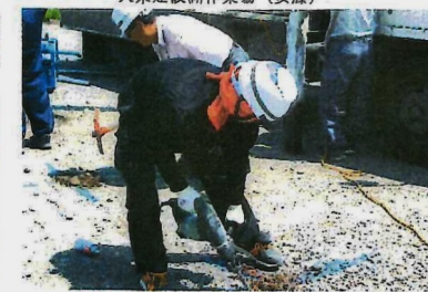
株倉金技建建設作業現場（礎）
