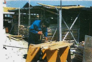
大栄建設㈱作業場（清水）
