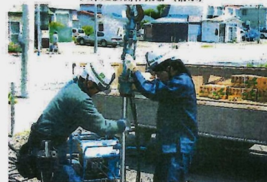
株倉金技建建設作業現場（落合）
