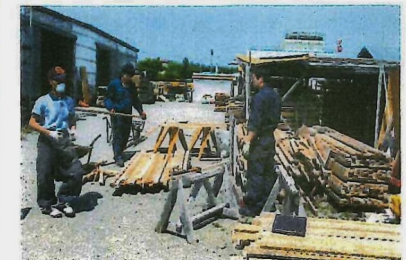
大栄建設㈱作業場（安藤、清水）
