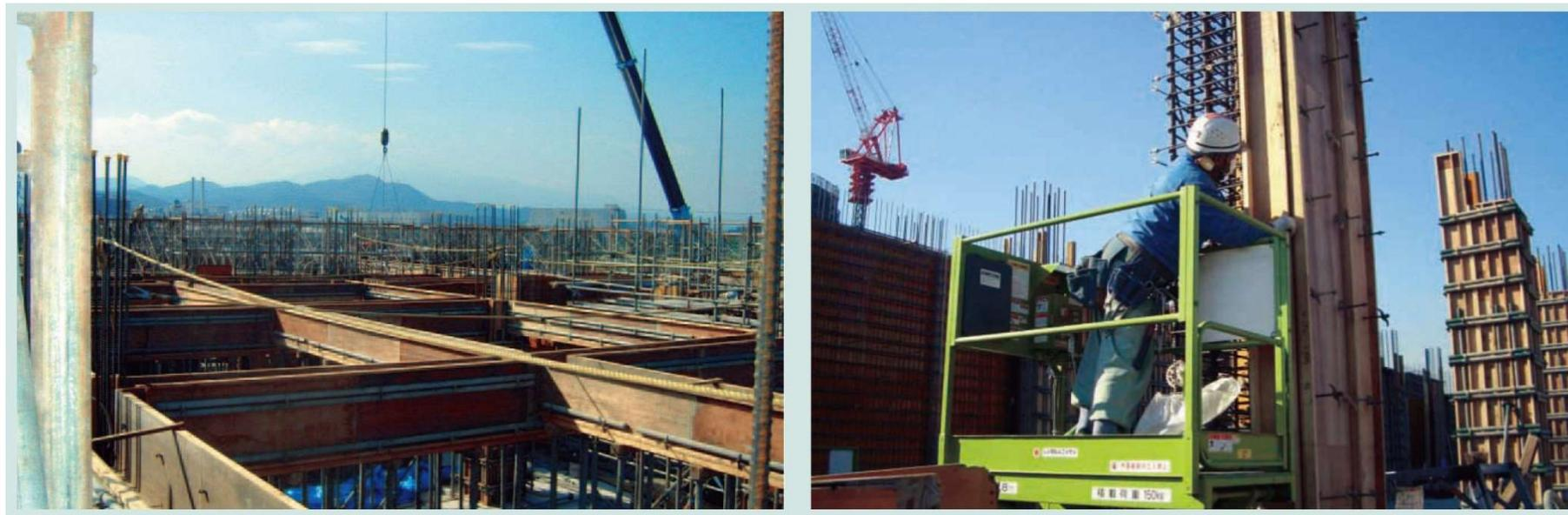
鉄筋コンクリートの建物は、まだ柔らかいコンクリートを建物の形の「枠」に流し込み、固まらせて作ります。
