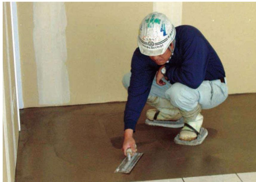
左官工事業は、工作物に壁土、モルタル、しっくい、珪藻土等を「こて」塗り、吹きつけなどにより、最終的な表面仕上げをする仕事です。長年培われてきた伝統技能によって確立されてきた多くの工法は、今もなお現代建築に柔軟に対応しています。近年、環境への配慮から珪藻土等の自然素材を使用した壁が見直され、手仕事による仕上げの多様性や味わいが再認識されています。
