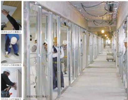
内装仕上工事とは、コンクリートで囲まれた空間に天井をつくり、壁をつくり、床を張って、人々が安全で快適に住んだり、働いたりできる部屋に仕上げる仕事です。ここでは、非住宅建築における基本的な工事の流れとともに、各工事における施工のポイントについて、整理しています。
