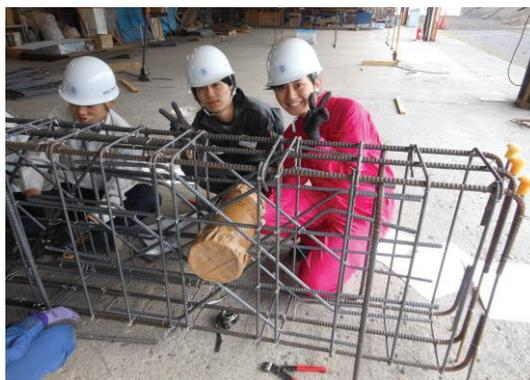
構造実習（梁貫通スリーブ補強）
