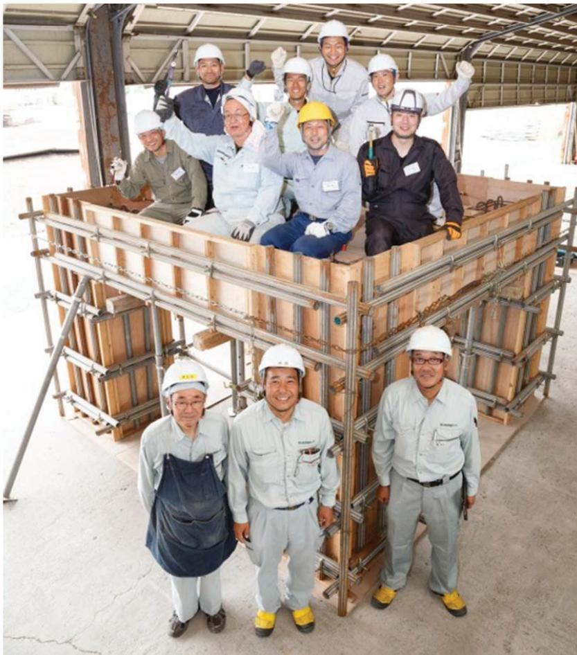
柱鉄筋、柱・梁・スラブ型枠 完成
