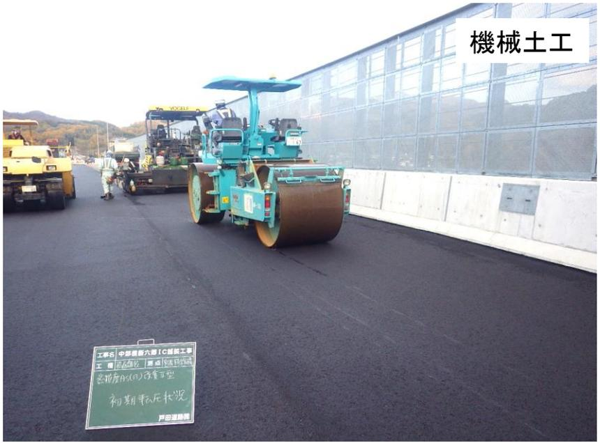
橋面工 アスファルト舗装施工状況 車道部
