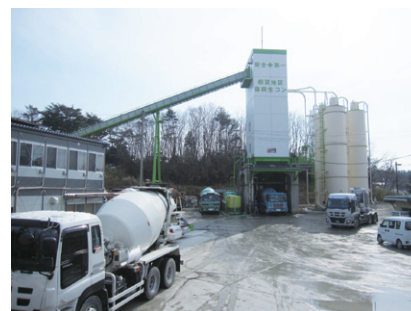
組合が設置した生コンクリート製造工場
