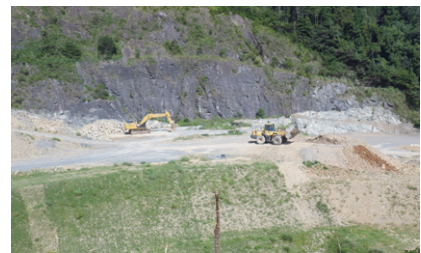
残土処理場（砕石場跡地）
