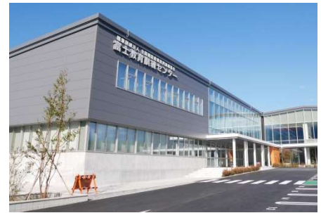
鉄筋・型枠 組立完了
