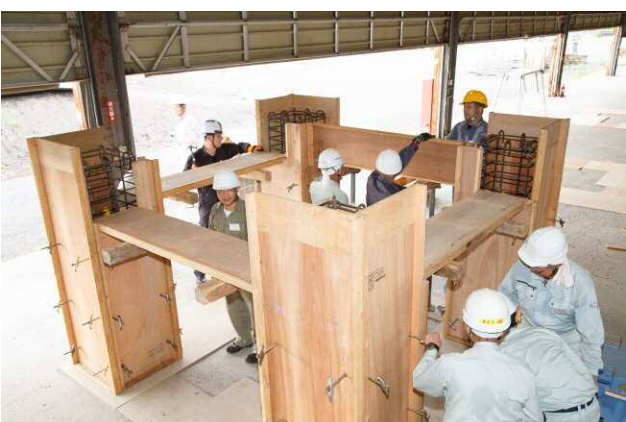
梁型枠建て込み・パイプサポート設置
