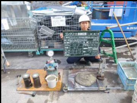
フレッシュコンクリート試験の立ち会い
