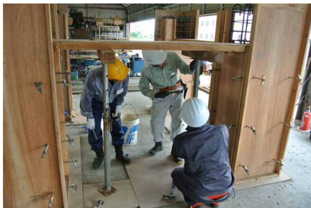
梁型枠建て込み・パイプサポート設置
