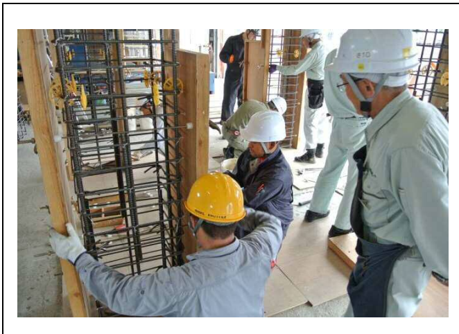
柱型枠建て込み
