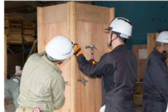
柱型枠建込み
