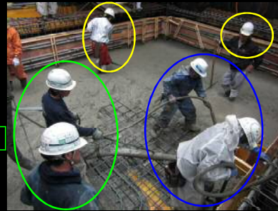
コンクリート工事に必要な人の手配
