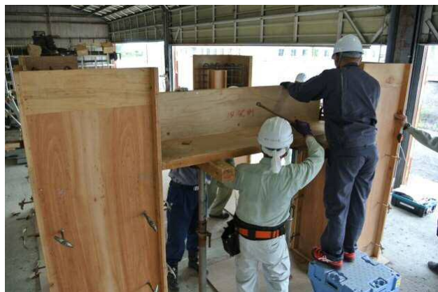
梁型枠建て込み・パイプサポート設置
