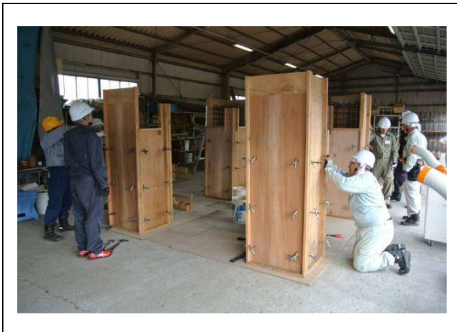
柱型枠建て込み・梁型枠建て込み
