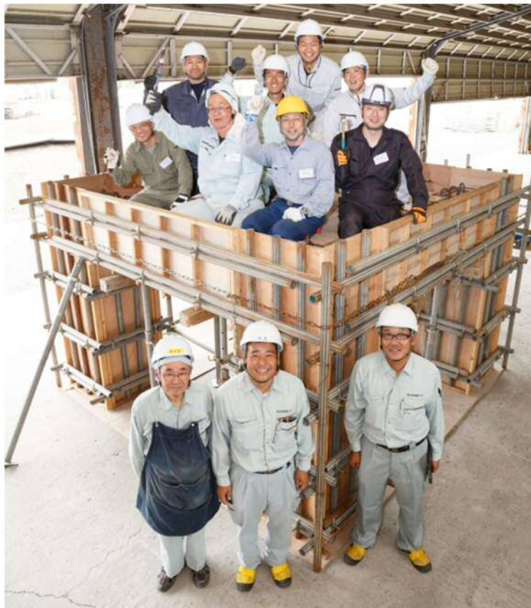
柱鉄筋、柱・梁・スラブ型枠 完成
