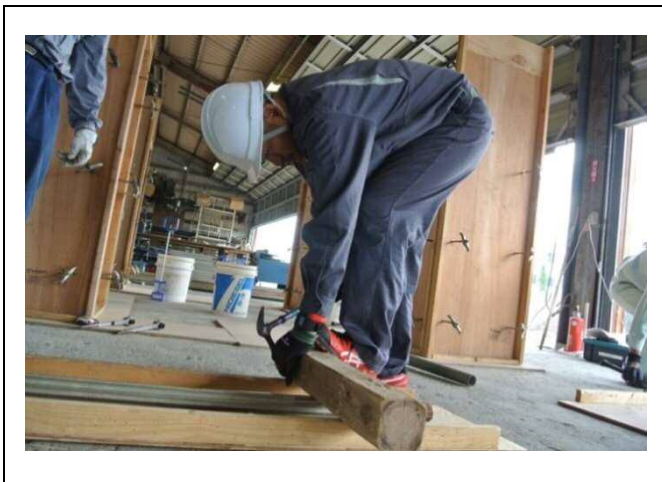
梁型枠建て込み
