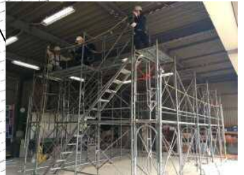
枠組足場組立
