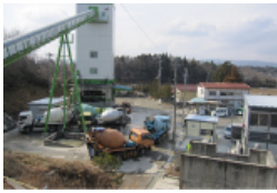
東日本大震災の復旧・復興のための 生コンプラント建設に債務保証
