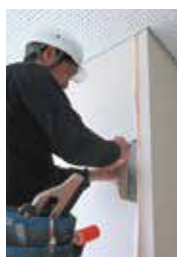
クロス仕上げ工事施工
