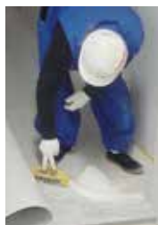
プラスチック床材施工
