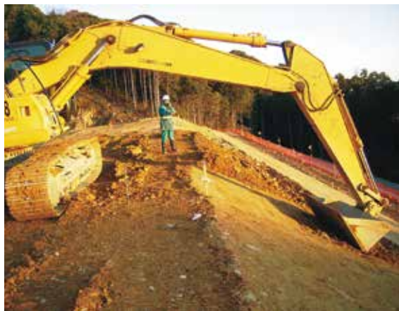
法面整形作業
