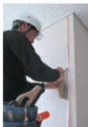
クロス仕上げ工事施工
