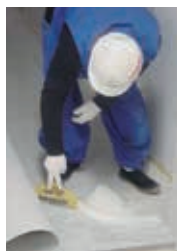
プラスチック床材施工
