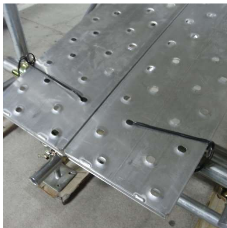
足場板の固定
