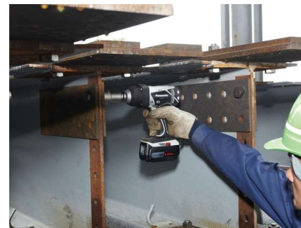
H形鋼スプライスプレートの締め結
