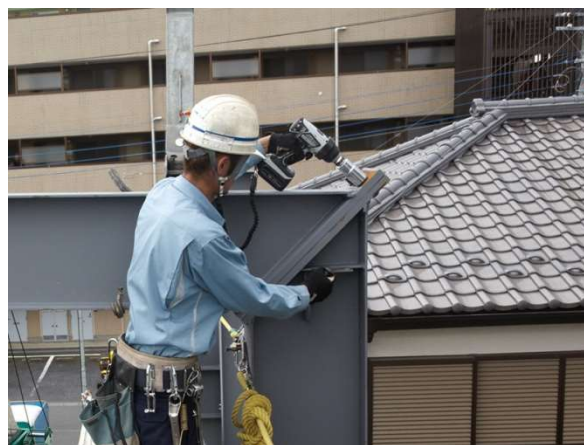
建て方工事の仮締め
