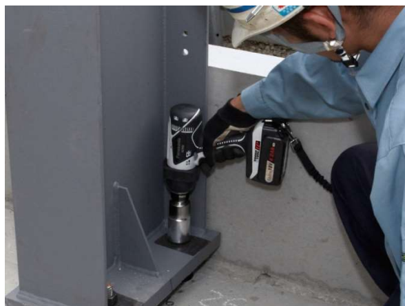
アンカーボルトの締め付け
