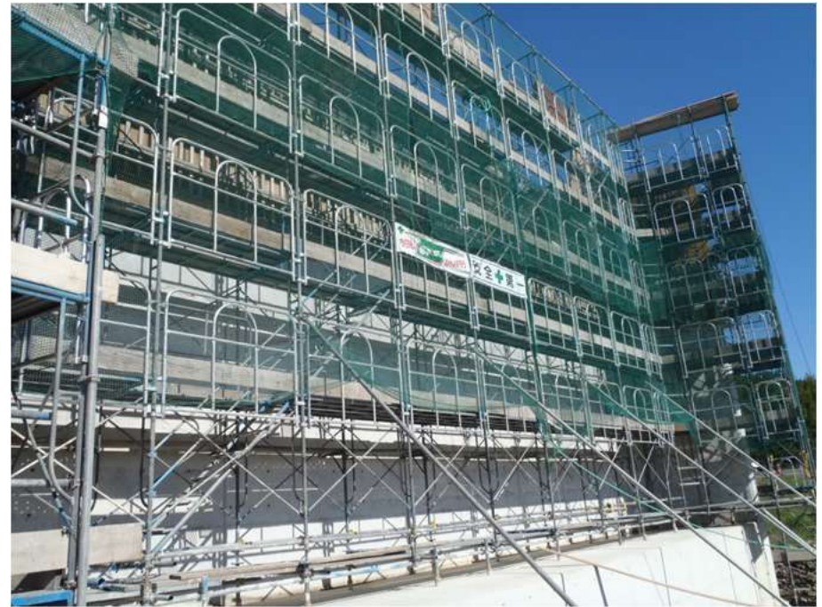
枠組足場(ビティ)
