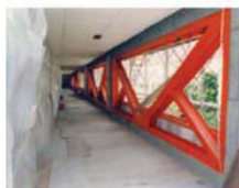
鉄骨ブレースによる壁の補強
